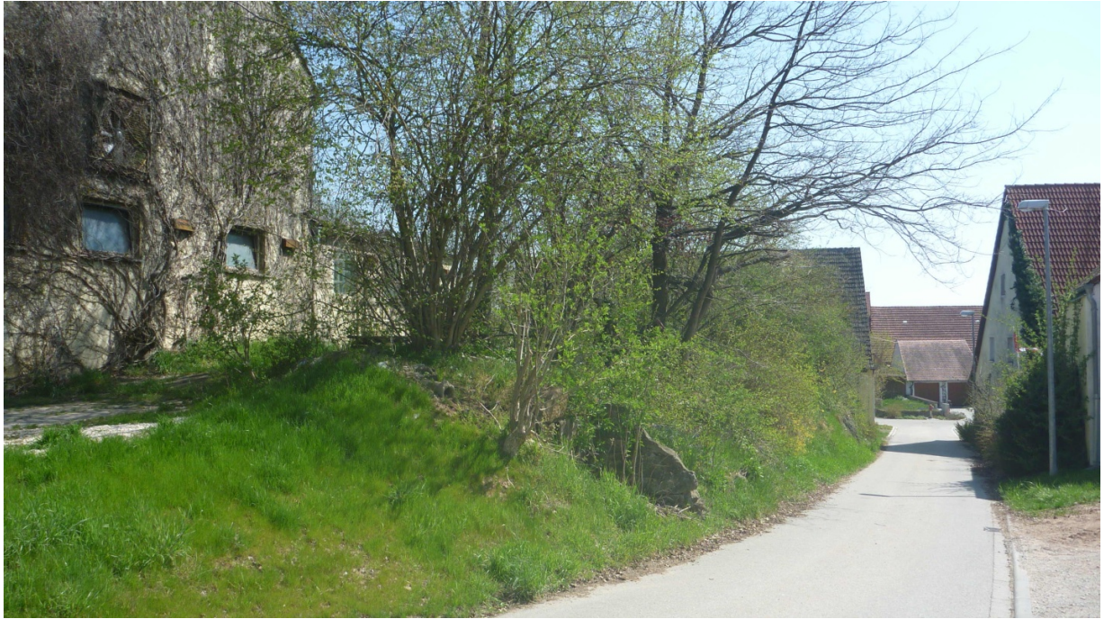
Abbildung 5: Böschungsbereich an der Straße
